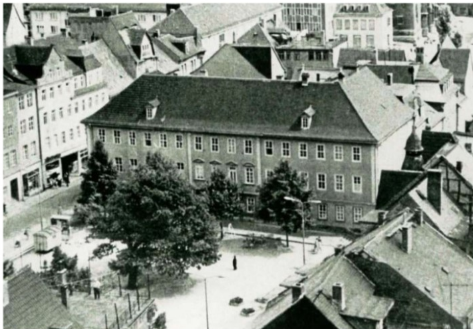
Der Eichplatz in Jena, so wie er in den 1960er Jahren aussah, also vor dem Abriss 1969.
